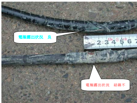
電線を直接露出させた検層電極の良否の例
