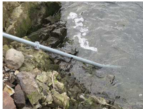
写真-8 水位計ガイドパイプの拡大
