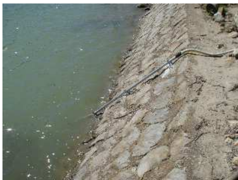
写真-7 護岸に設置した水位計ガイドパイプ
