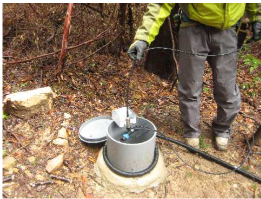
図-5 水位計の挿入状況
