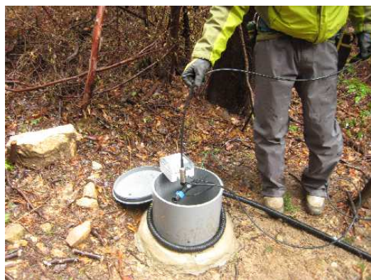
図-5 水位計の挿入状況
