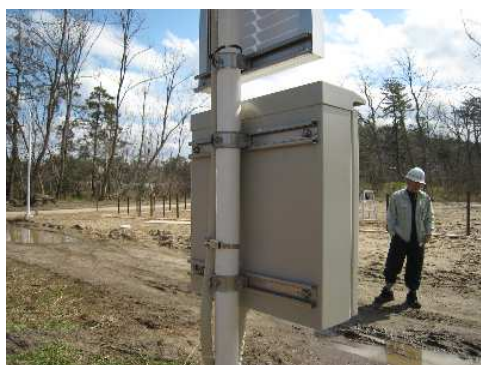
写真-5 ボックスの単管固定クリップ
